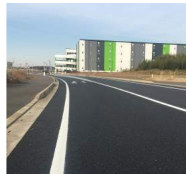
部分開通した千葉竜ヶ崎線バイパス
