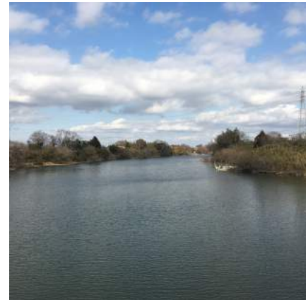
護岸整備が行われていない長門川
