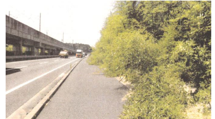
歩道への竹の垂れ下がり(印西市吉高)
