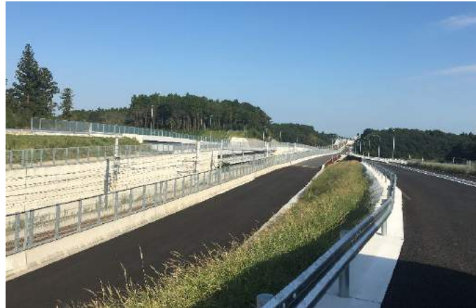
北千葉道路工事区間（H28.10 印西市若萩 [印旛日医大近く]）
