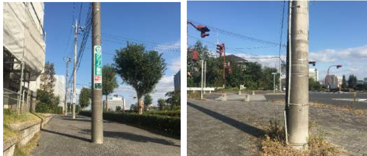
歩道内の電柱（印西市木刈）…電柱標識板さえ設置されていない
