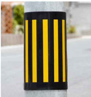
衝突を防止する電柱標識板
