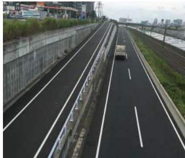
北千葉道路 草深オフランプ
